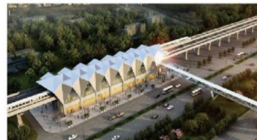
轨道交通建设
